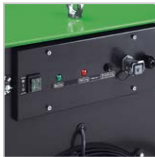
Schalt- und Bedienungs- tableau geschützt angeordnet
