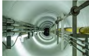
Niederdruckleitungen
